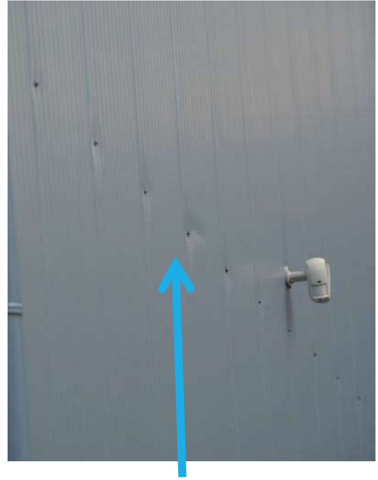
próba wzmocnienia dodatkowymi wkrętami
